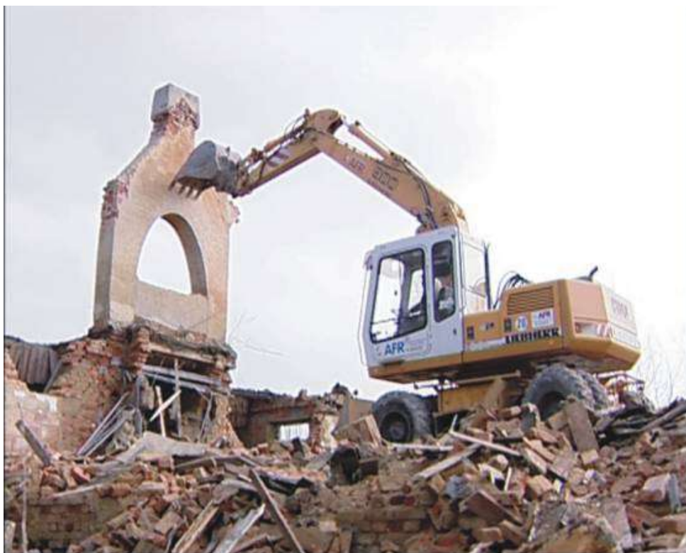
Pomalé bourání kasáren Hamrníky v roce 2007 ( zdroj )
