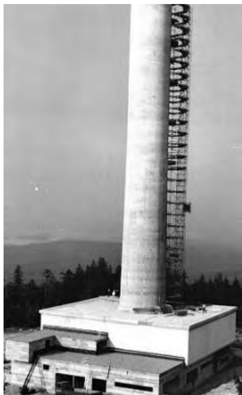
Postup výstavby věže
