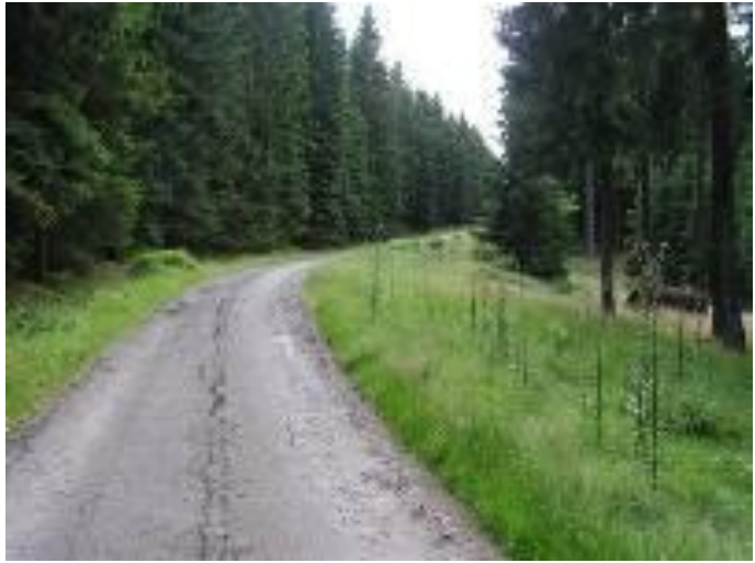
Zachovalá lesní asfaltka nahoru na stanoviště
