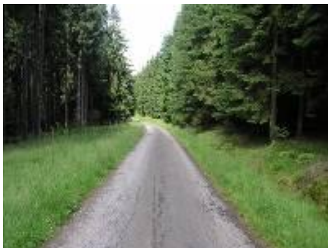
Zachovalá lesní asfaltka nahoru na stanoviště
