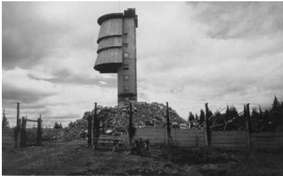
Postupné bourání stanoviště Poledník před jeho přebudováním na rozhlednu.
