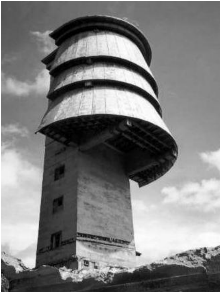
Obrázek – bourání nevyžitelných budov a postupného „odhalování“ těla věže. Všimněte si, že anténní prostor je velmi podobný té na nové čerchovské věži a že v něm ještě nejsou vyřezána okna jako nutný předpoklad využití prostor bez přívodu elektrického proudu.
