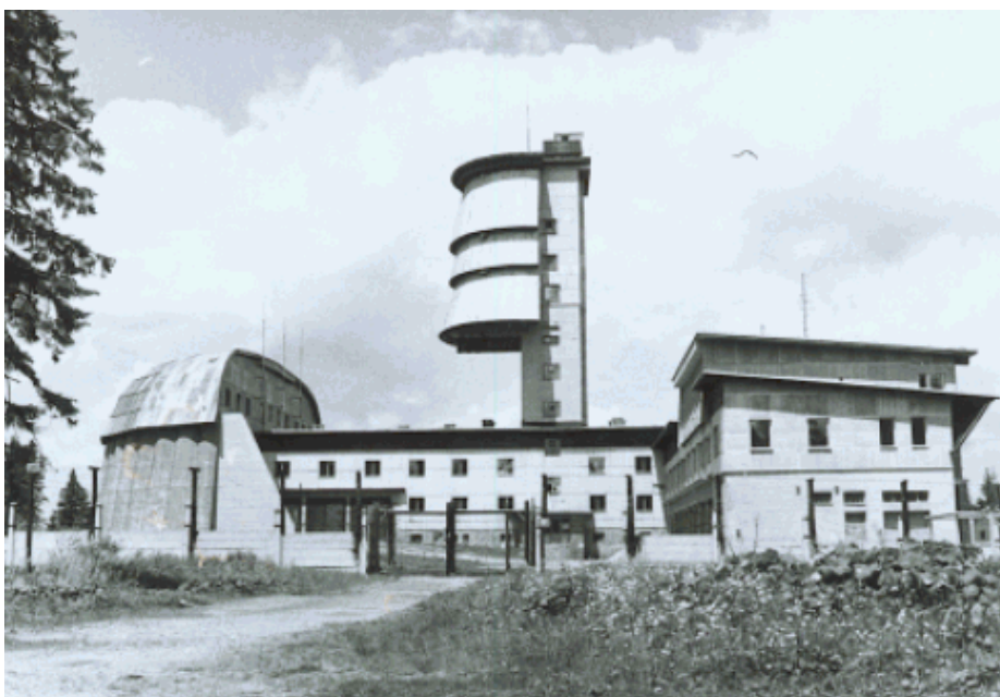
Podoba stanoviště Poledník po přestavbě z 60. let Pohled od vstupní brány
