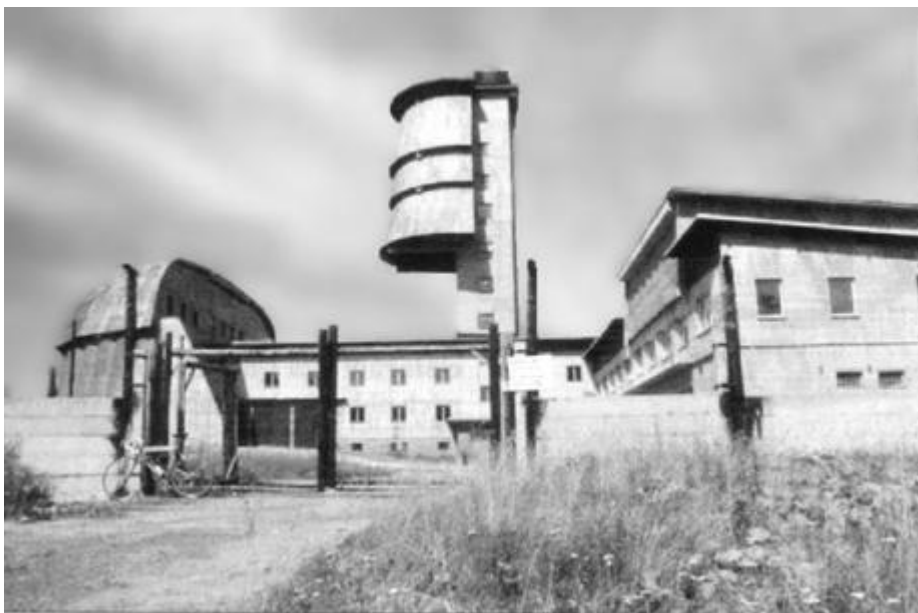
Podoba stanoviště Poledník po přestavbě z 60. let Pohled od vstupní brány
