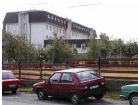
Hlavní provozní budova bývalých kasáren v posádce Klenčí pod Čerchovem (2002) (Nyní bytovka, v době minulé měla budova plochou střechu bez nástavby)
